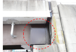
主桁端部塗り替え補修例
